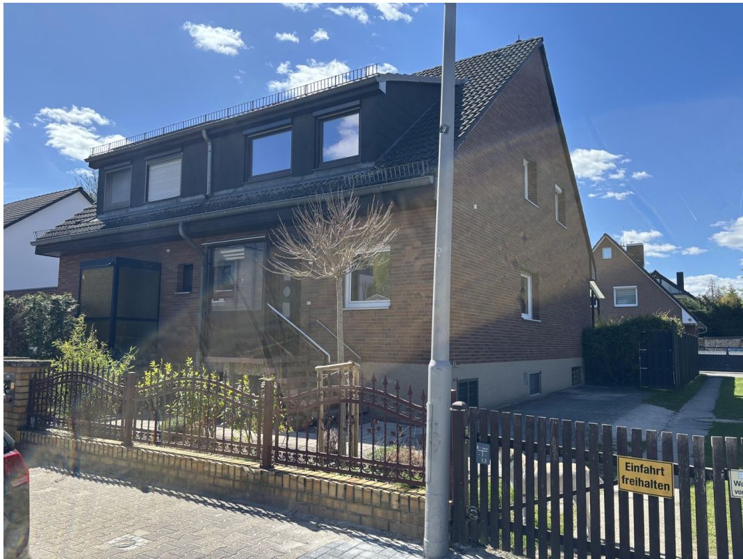
Blick von der Straße
