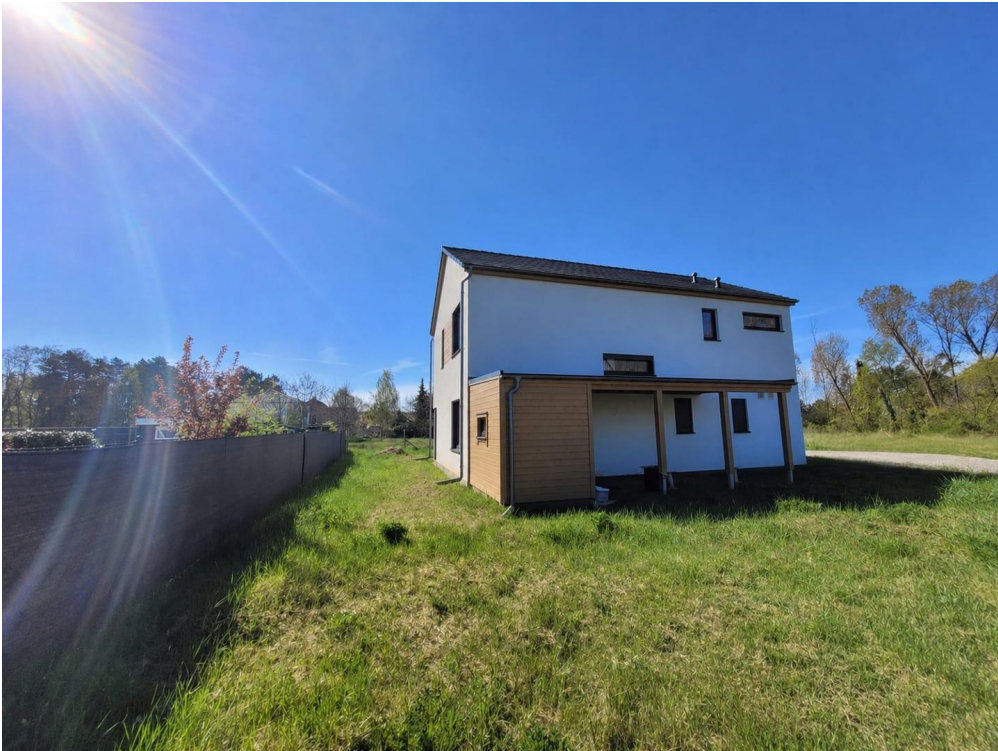
Ansicht Nord + Carport
