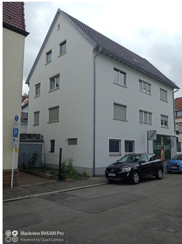
Hausansicht von Südwesten
