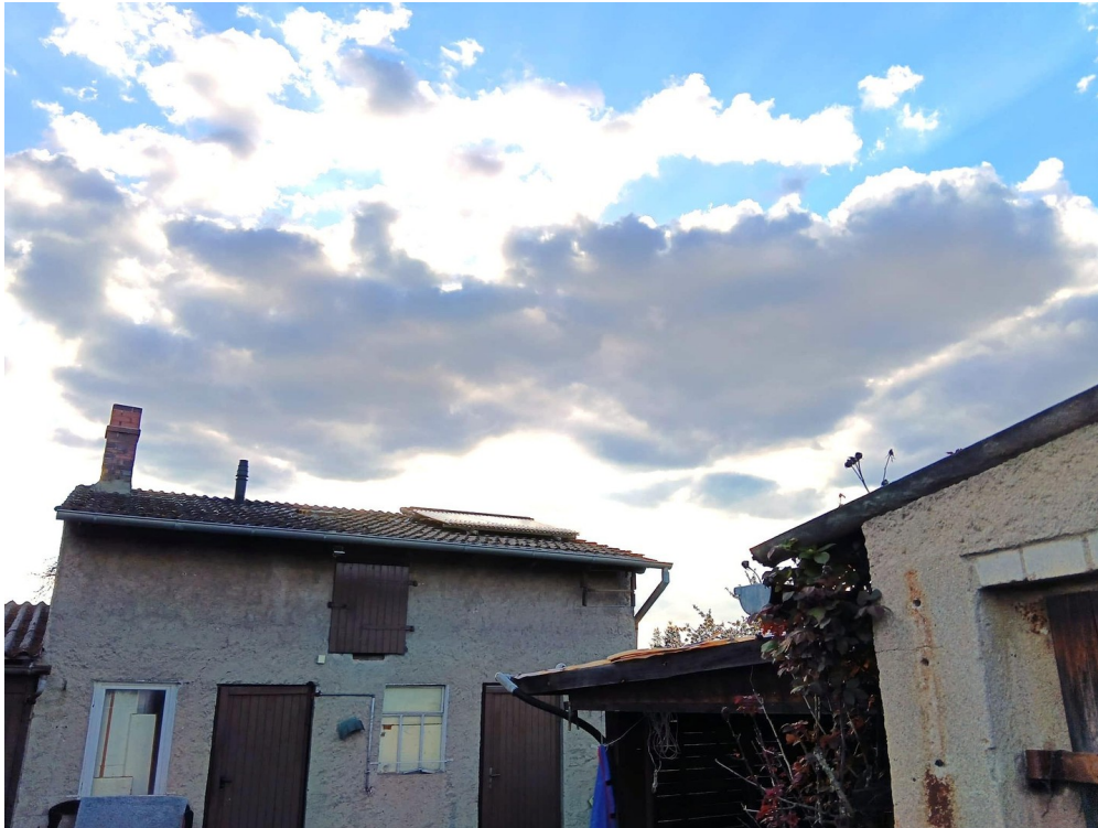
Nebengebäude mit Solar
