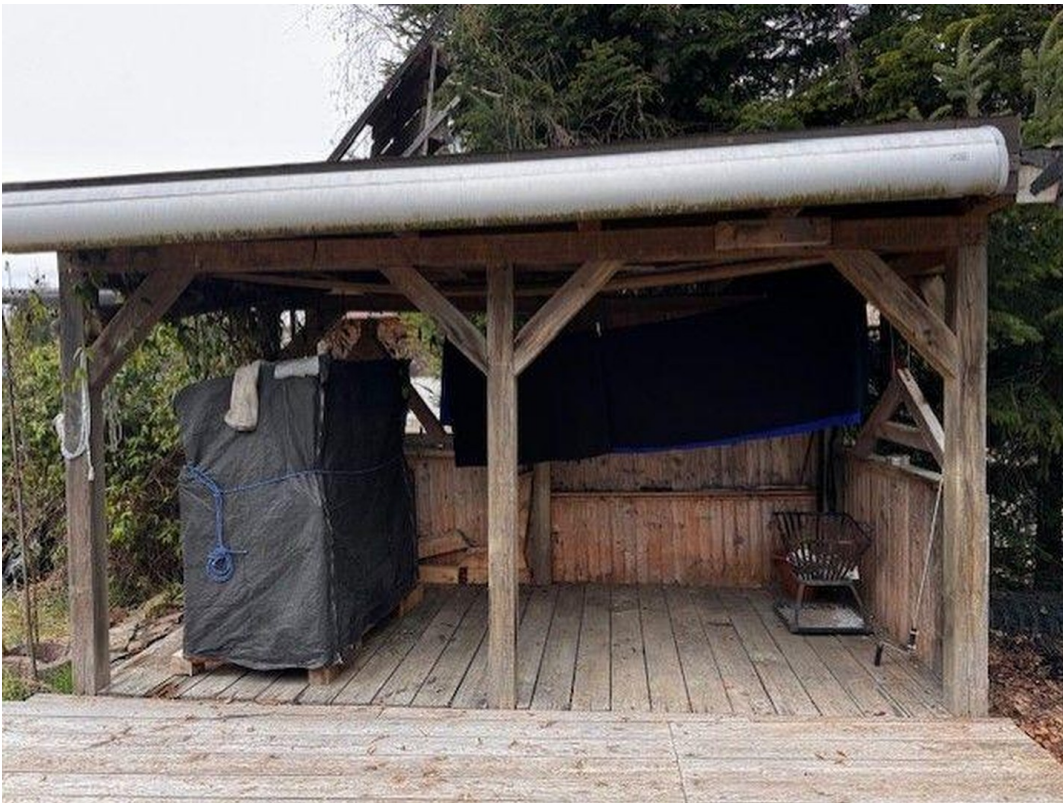
Unterstand bei Terasse
