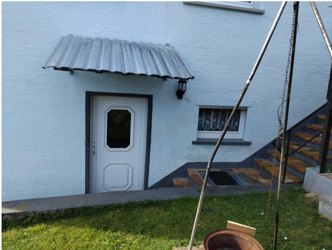
Zugang Wohnung UG
