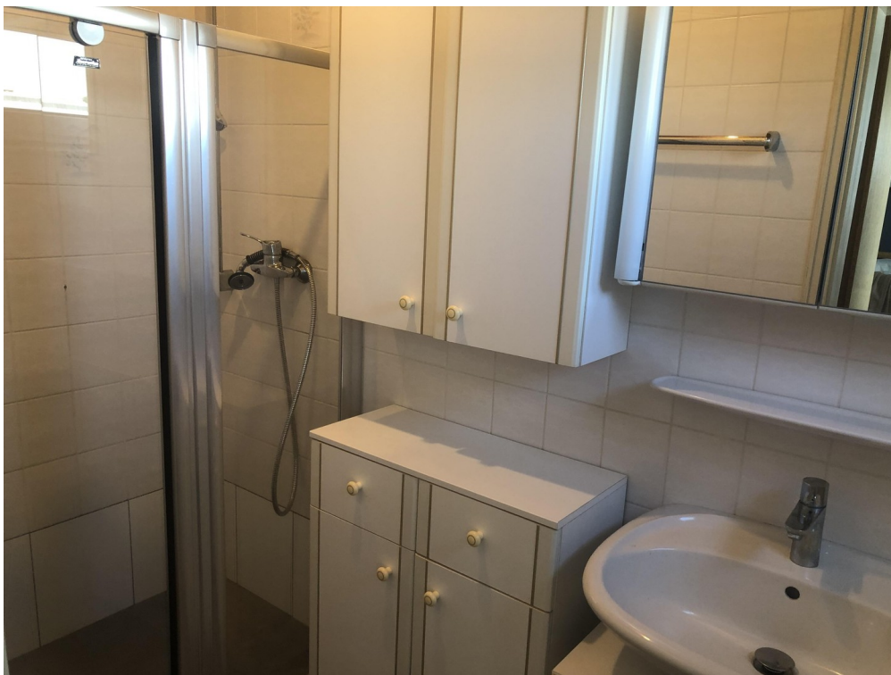
Duschbad mit Fenster
