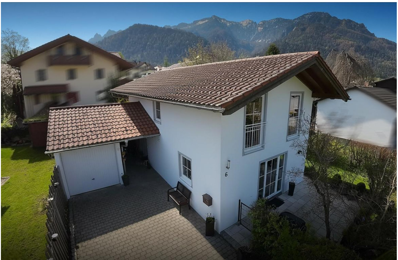
Einfahrt und Garage
