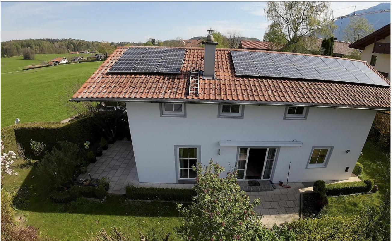
Terrasse Westen und PV Anlage
