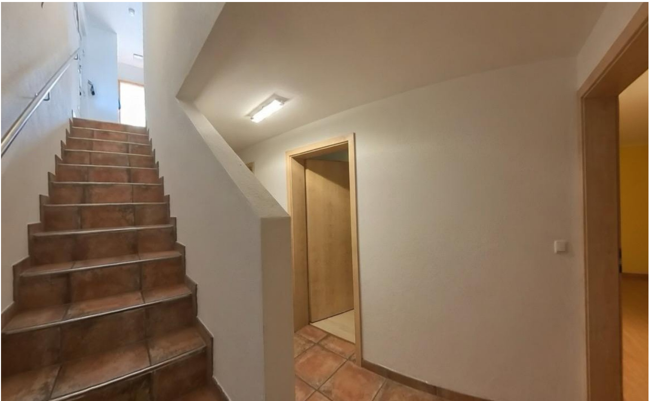
Treppe und Flur Keller
