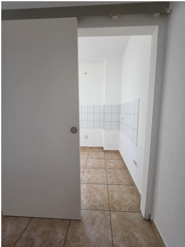
Eingang Küche (Schiebetür)
