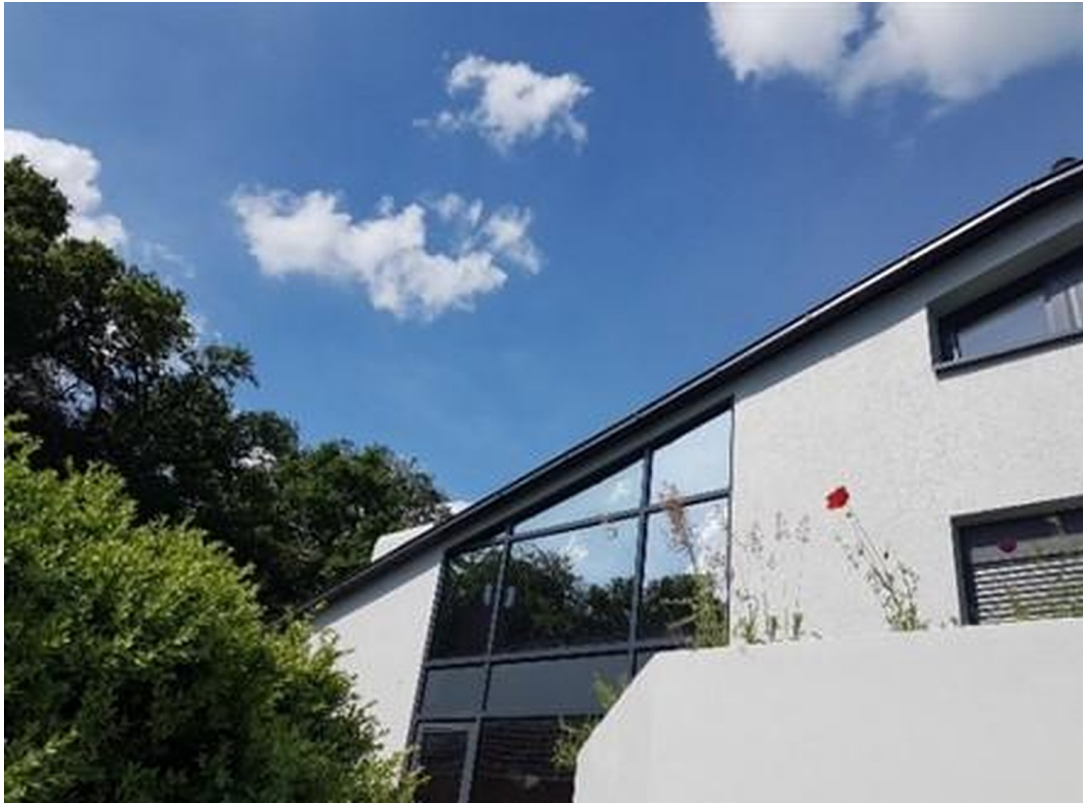
Ansicht Haus Front
