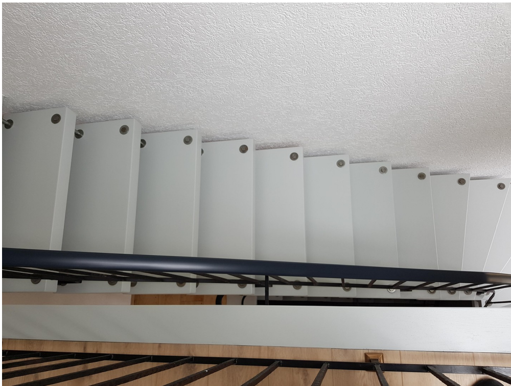
Treppe vom OG aus
