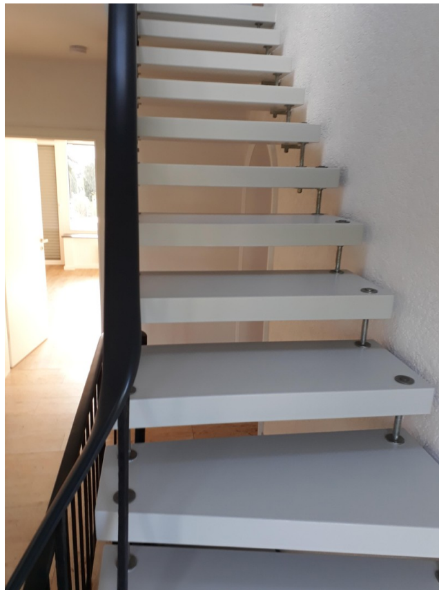
Treppe / Flur vom EG aus
