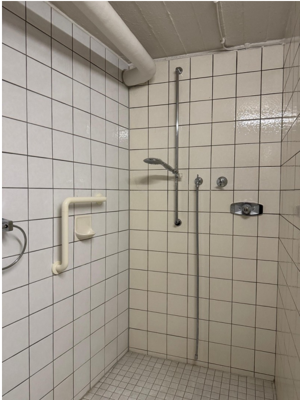
Dusche im Keller
