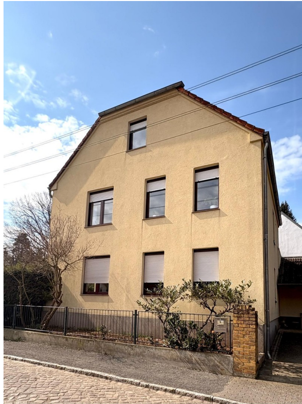
Hausansicht - Straße II
