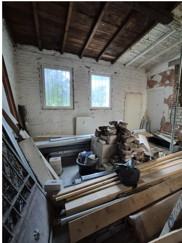
Zimmer im Rohbau
