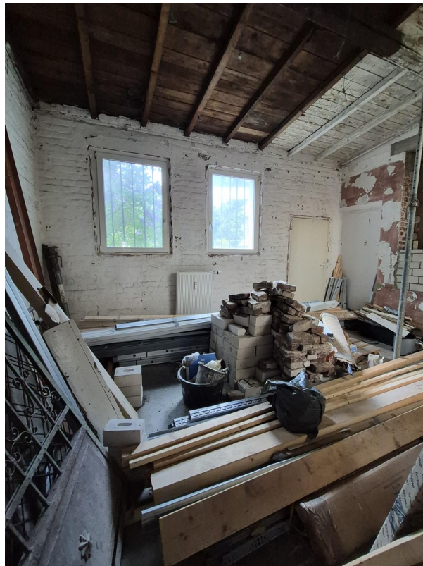
Zimmer im Rohbau
