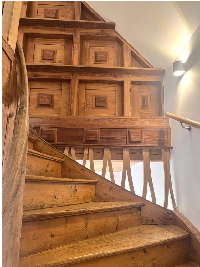
Treppe in das 2. OG
