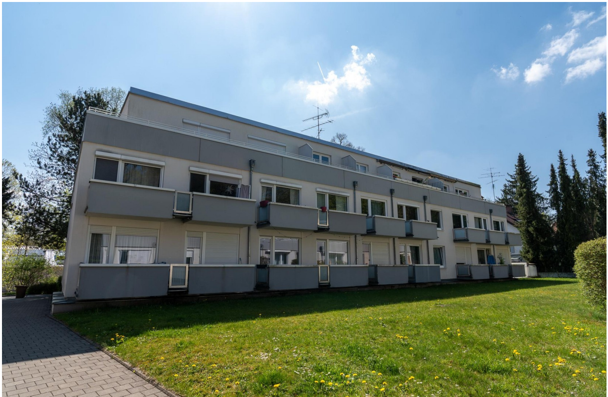
Gebäuderückseite mit Balkonen
