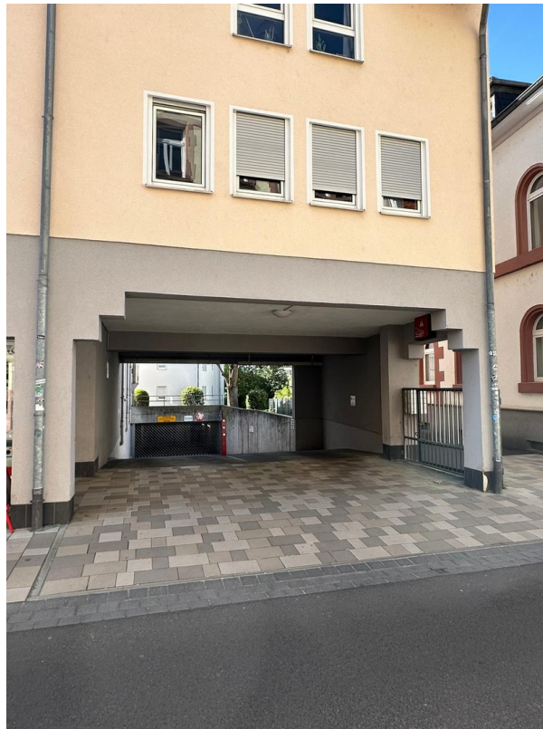
Einfahrt zur Tiefgarage
