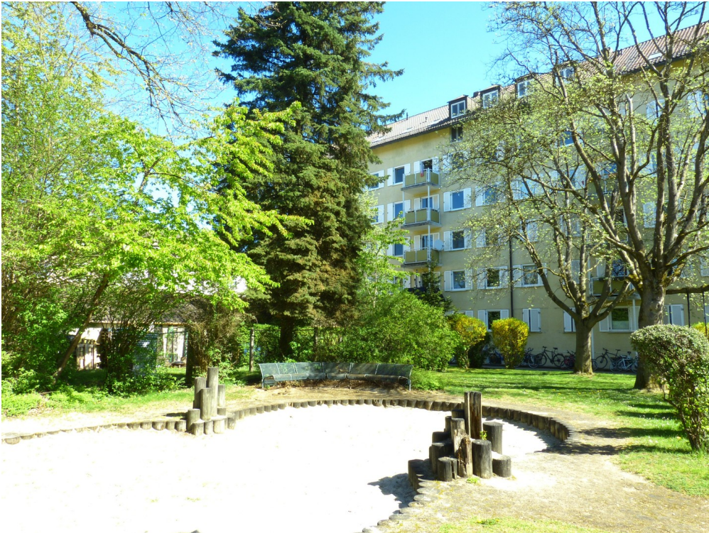
Außenansicht auf das Gebäude
