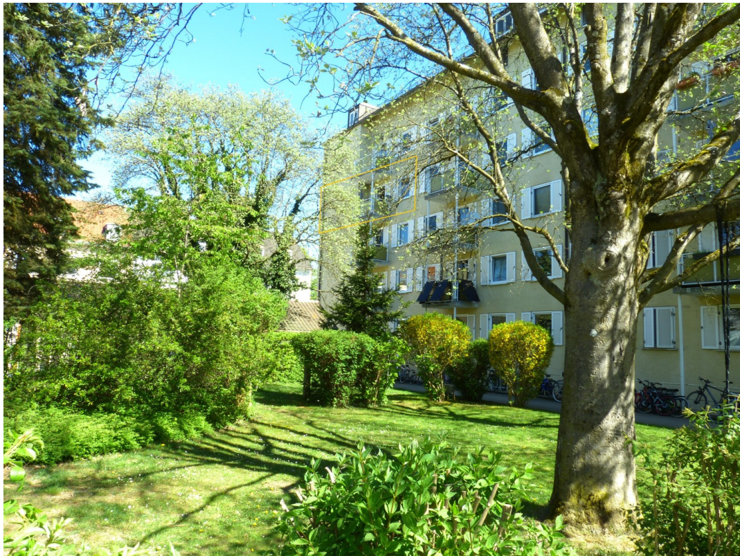
Außenansicht auf das Gebäude
