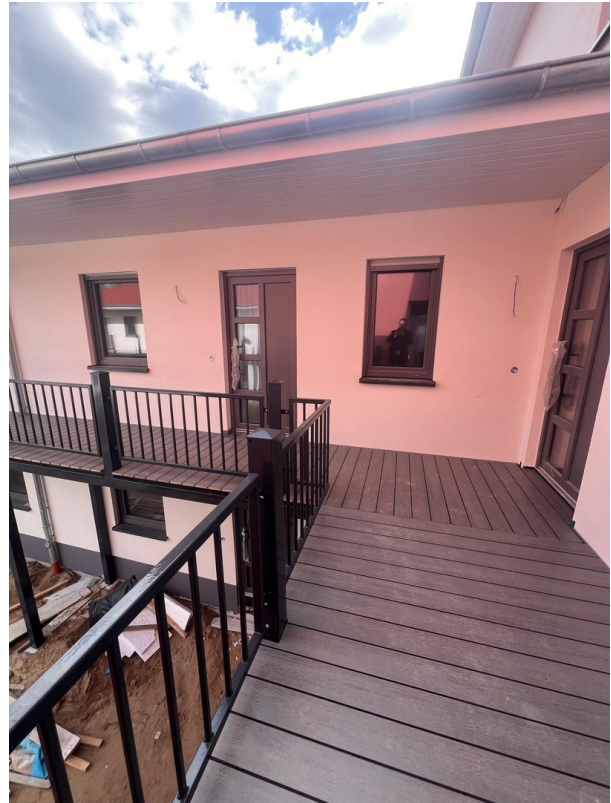
Laubengang und Zugang
