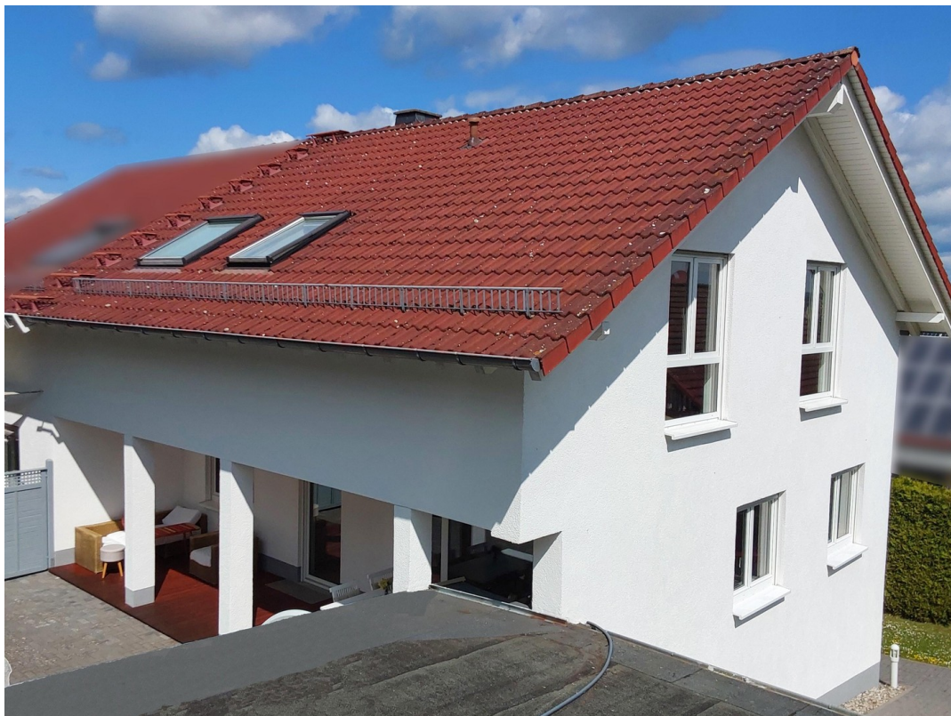
DHH und überdachte Terrasse
