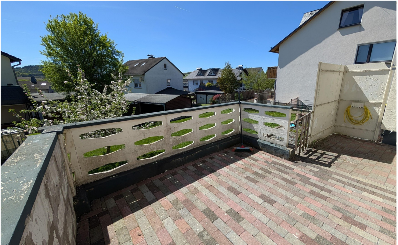
Terrasse EG / Nach Westen
