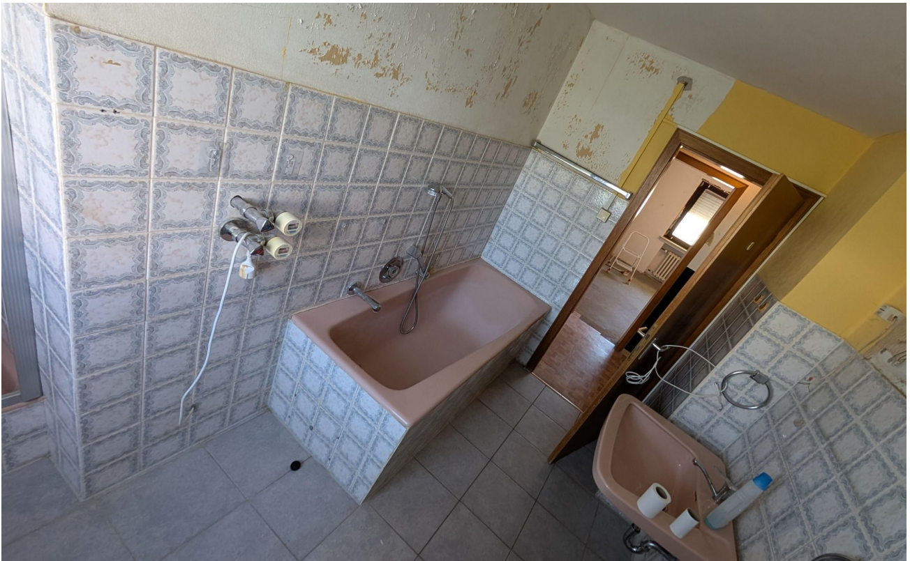
Bad & WC EG mit Dusche + Wanne
