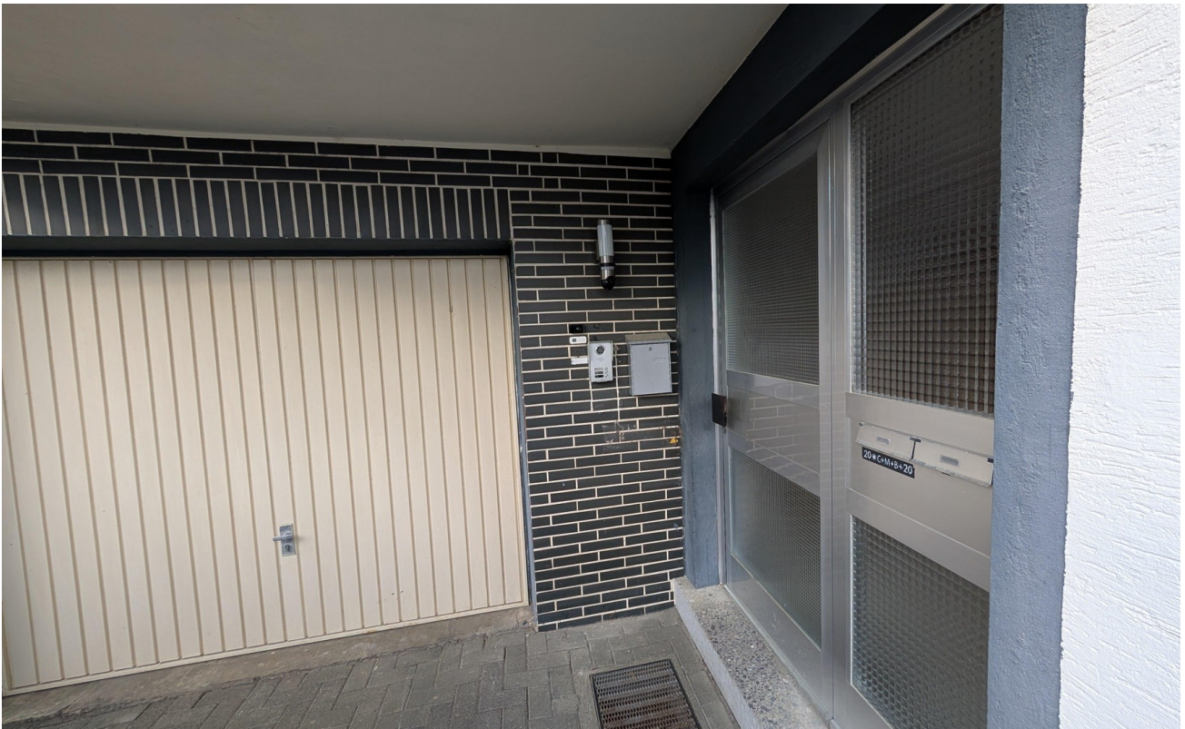
Eingang und Garage 1
