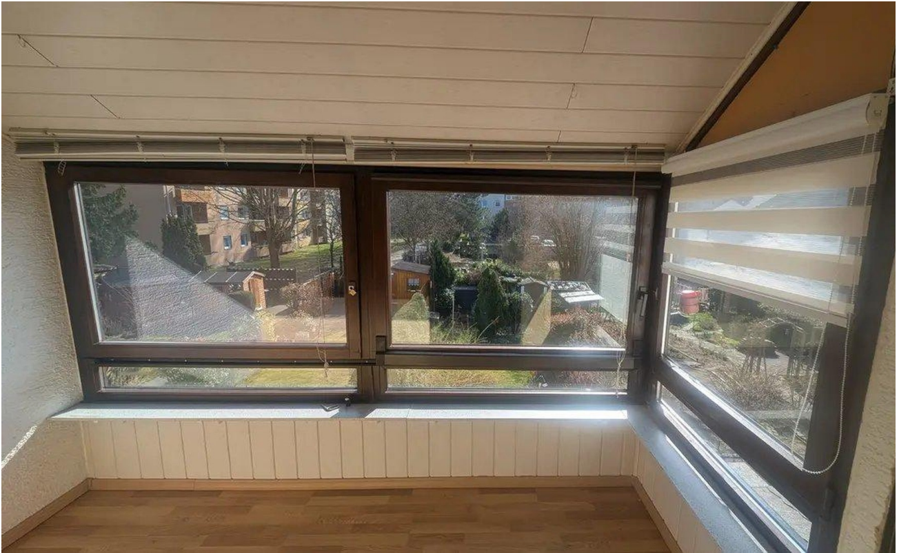
OG verglaster Balkon
