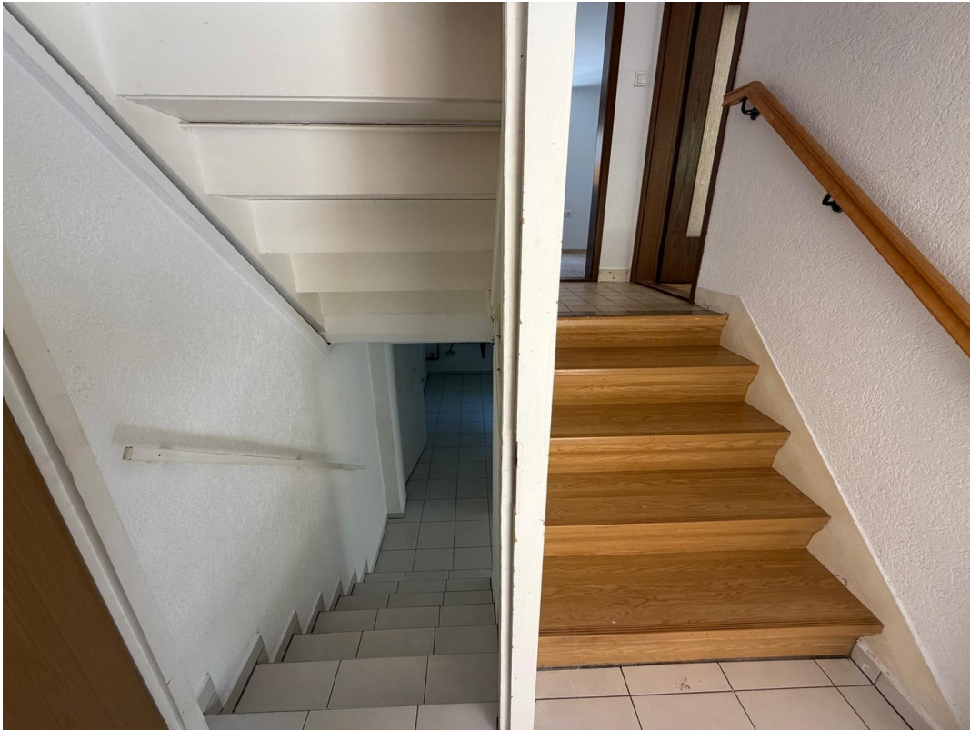
Treppenhaus EG in UG
