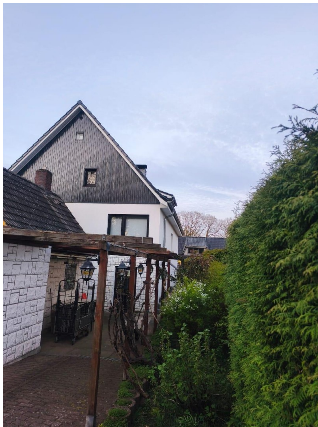
Rückseite des Hauses, Terrasse
