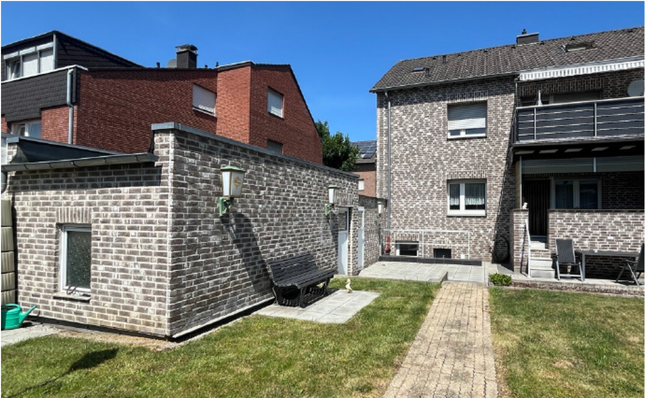
Garage und Terasse
