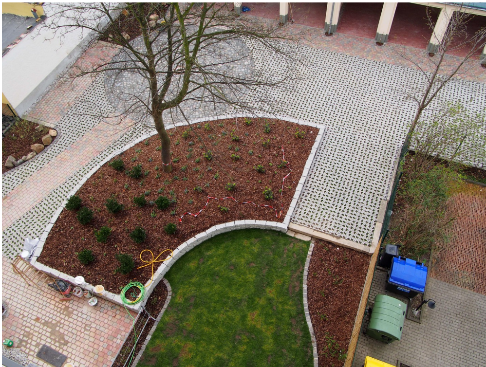
Kfz-Stellplatz und Innenhof
