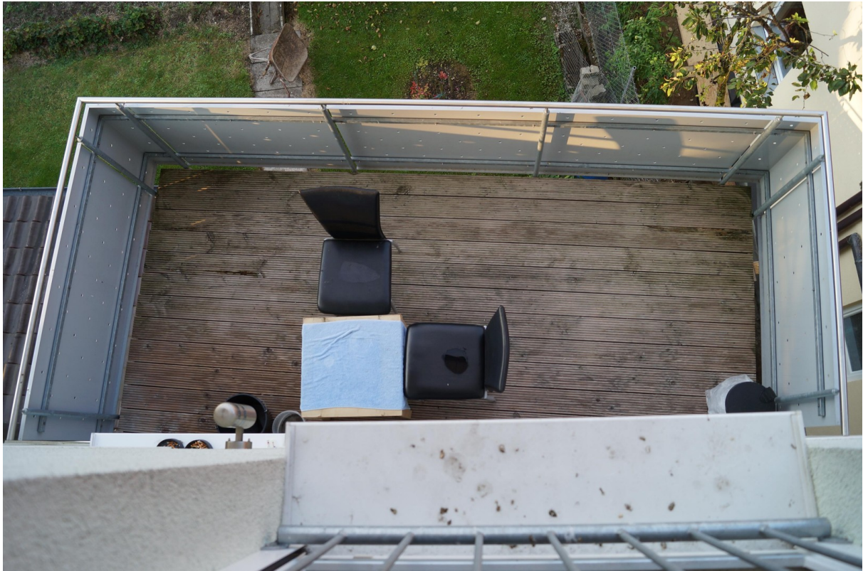
Anbau 2.OG Balkon
