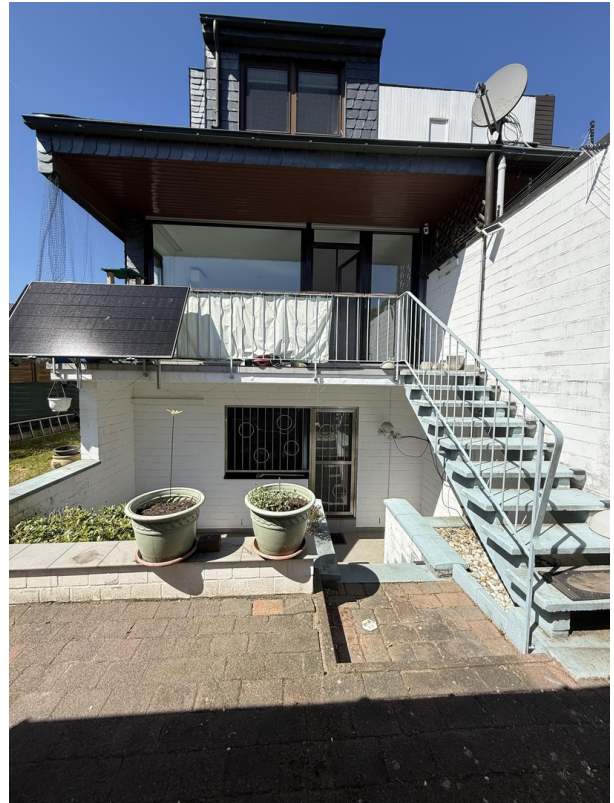
Außentreppe zum Balkon
