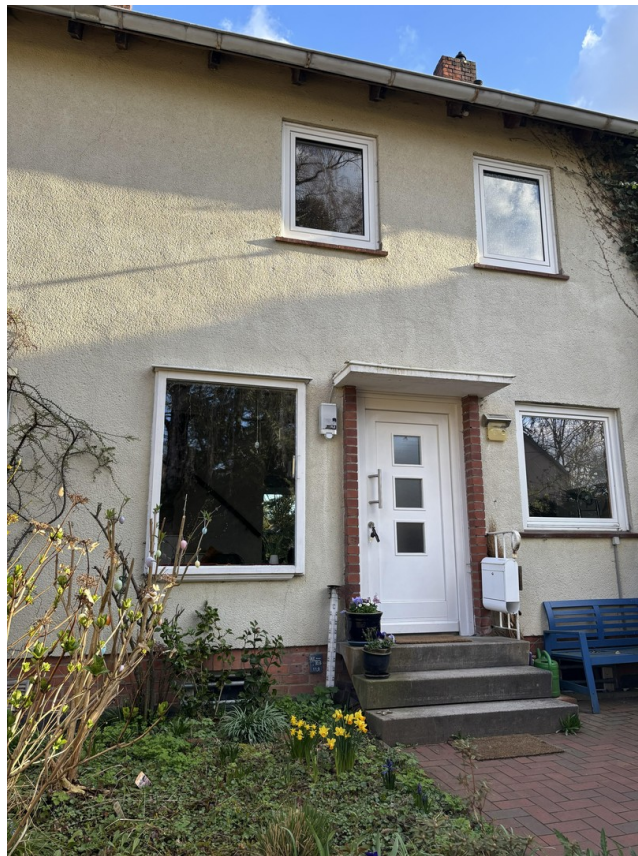
Reihenmittelhaus Ansicht vorn
