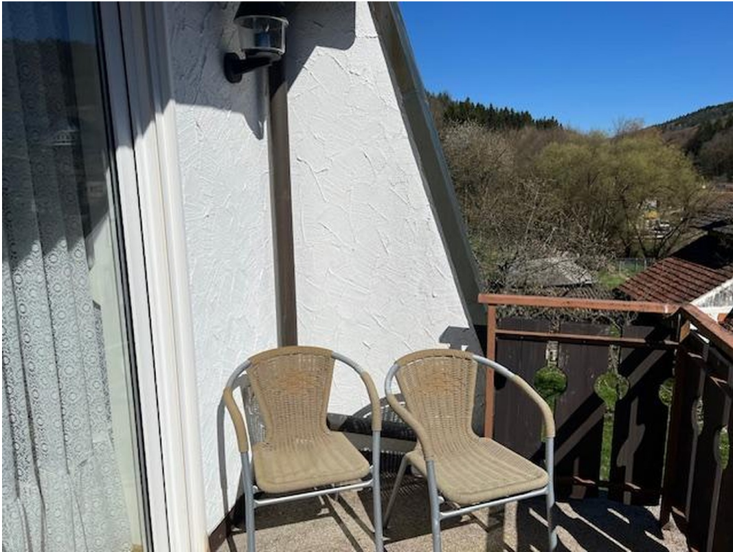
Balkon im 2. OG
