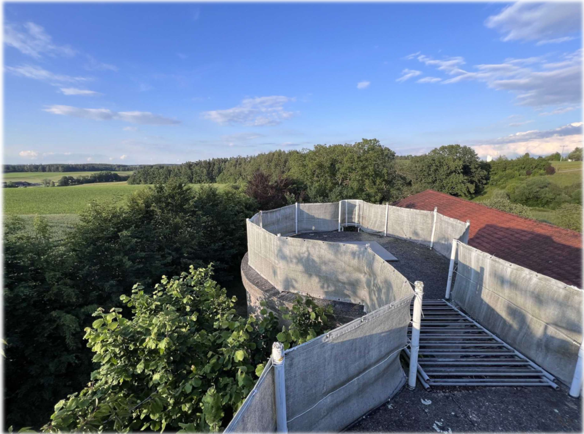
8. Bild: Aussicht von den Silotürmen in Richtung Osten.
