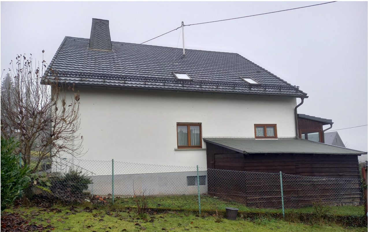
Hausrückseite mit Schuppen
