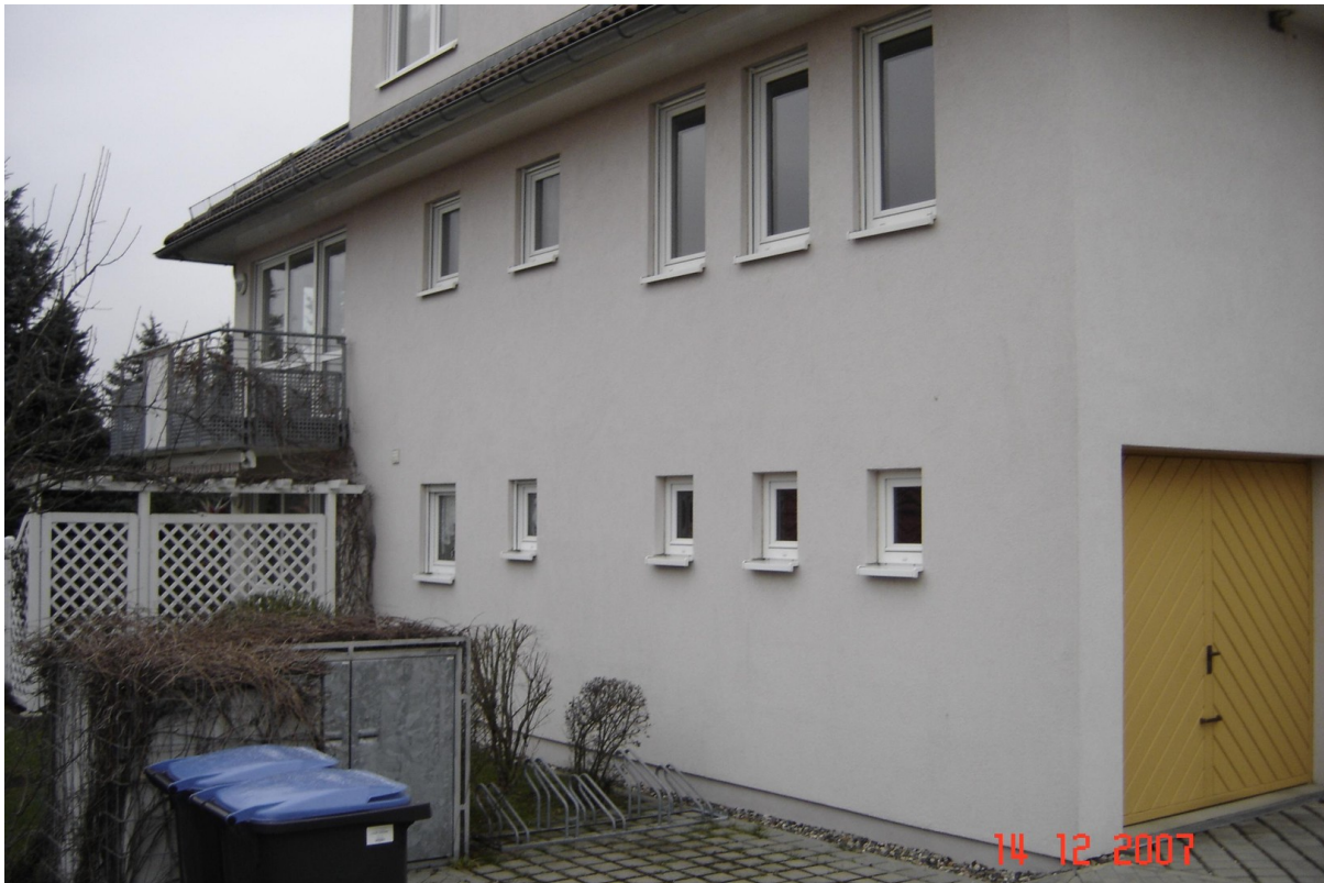
Fassade in Westrichtung
