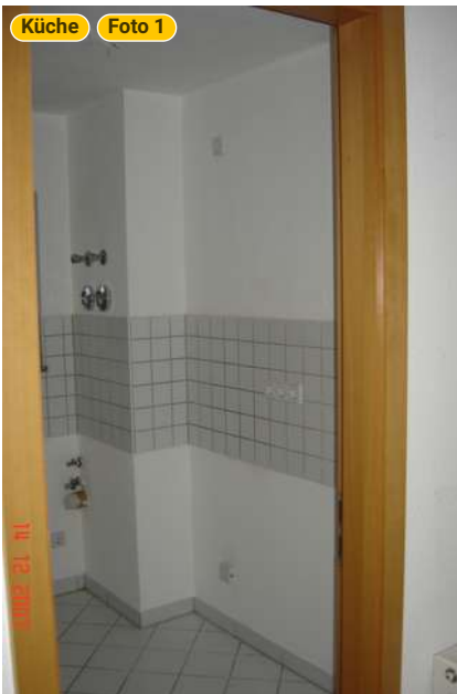
rechte Wand: Fliesenspiegel mit Armaturen
