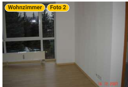
Wohnzimmer: Glasfront (nordseitig) und Trennwand zur Küche
