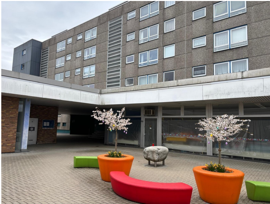
Gebäude von außen
