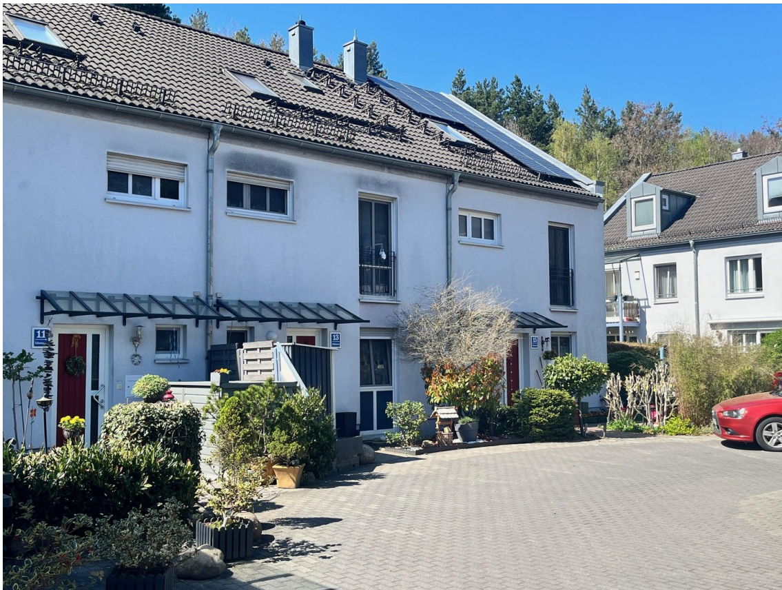
Blick auf die Reihenhäuser
