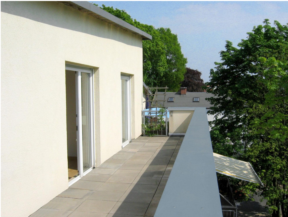
Dachterrasse zum Süden
