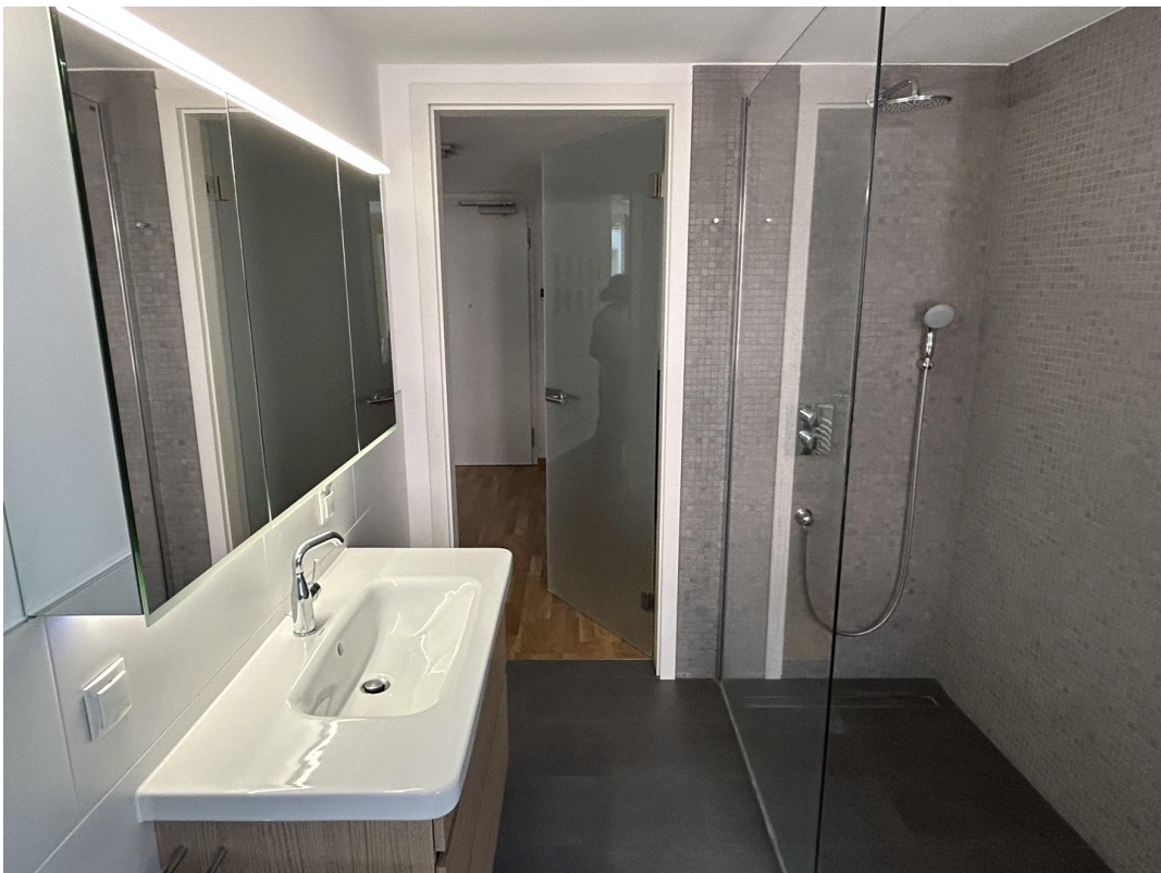
Bodengleiche Dusche/ Glaswand
