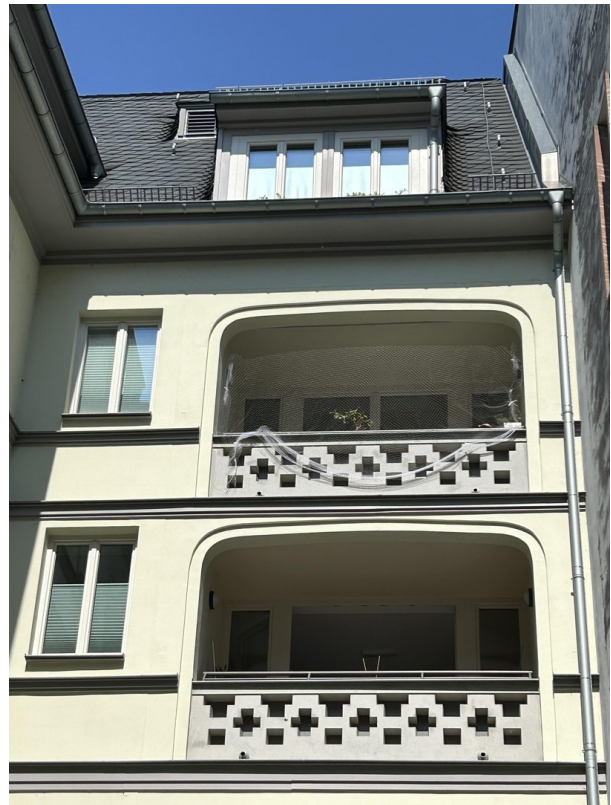
Loggia vom Wohnungsinnenhof
