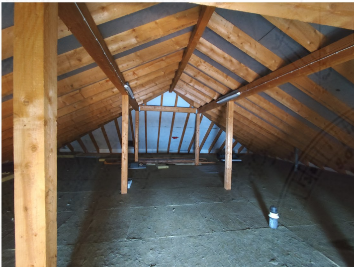
Ungenutzter Dachraum (max. 3,4m Deckenhöhe)
