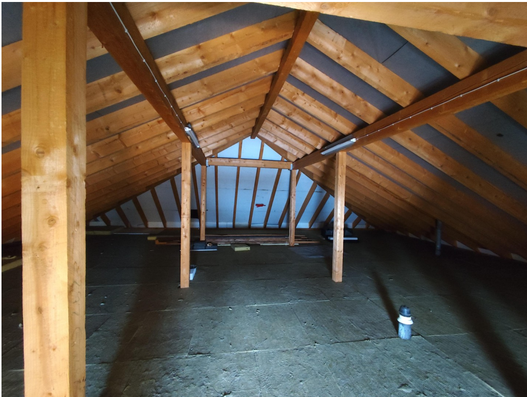
Dachraum 3,6m Höhe
