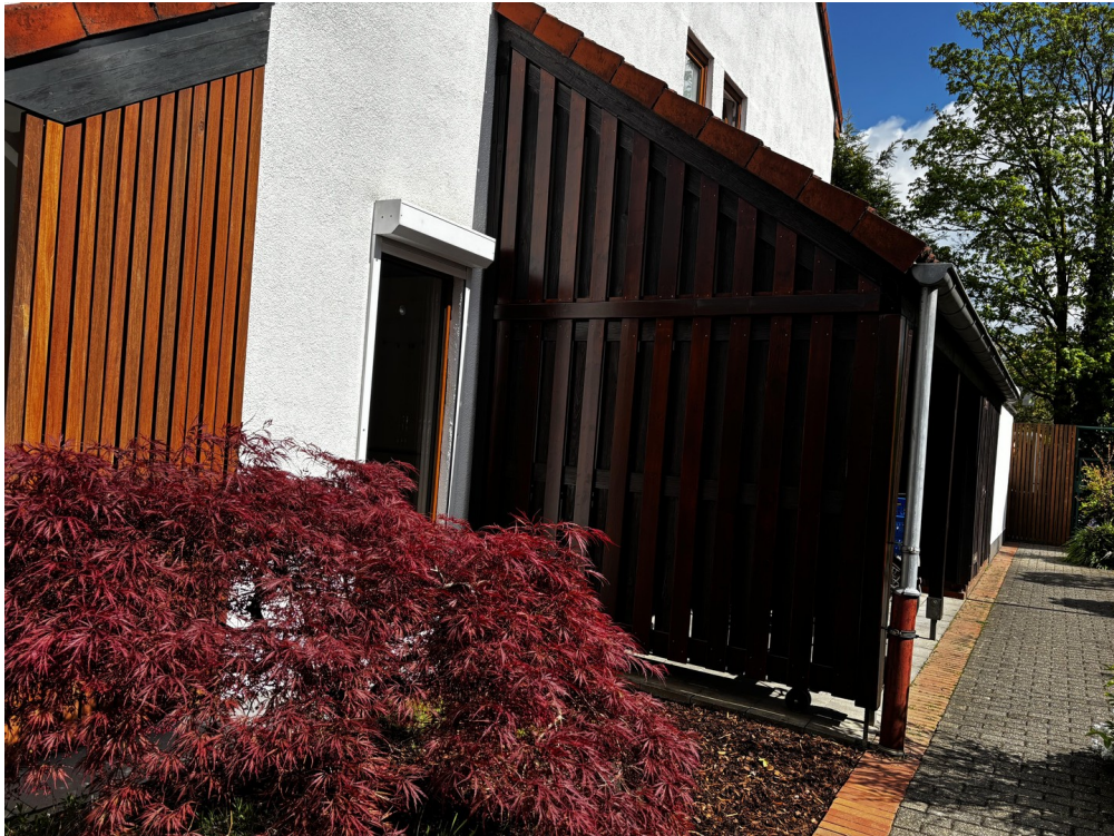
Außenansicht, Zugang Garten
