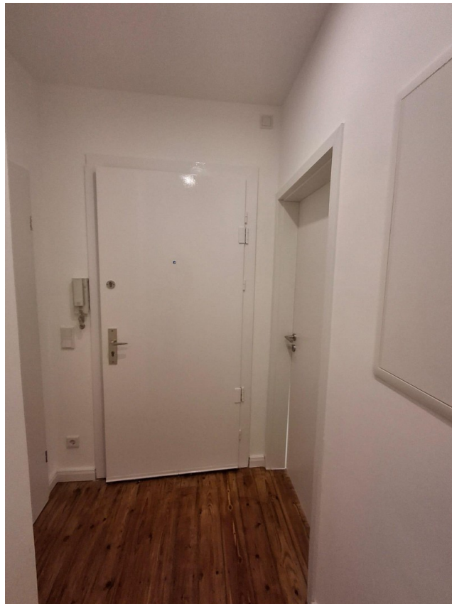
Neue Elektrik-im Flur
