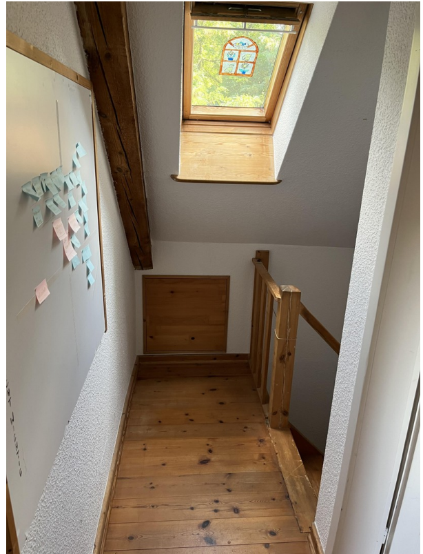
Aufgang ins Dach
