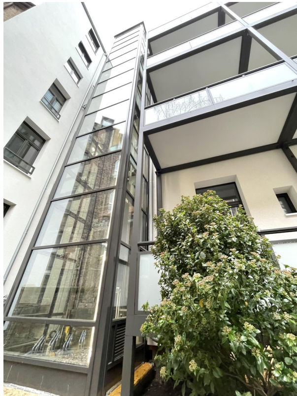
Neuer Aufzug u. Balkone
