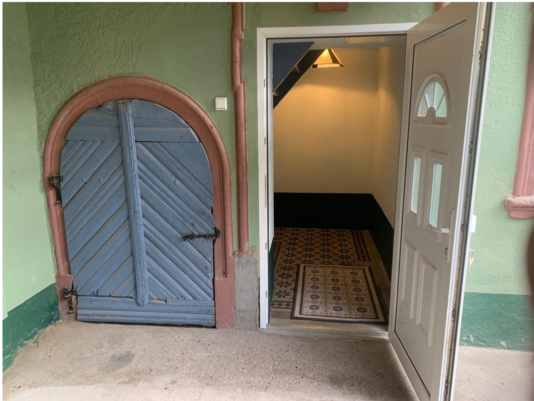
Eingang vom Hof
