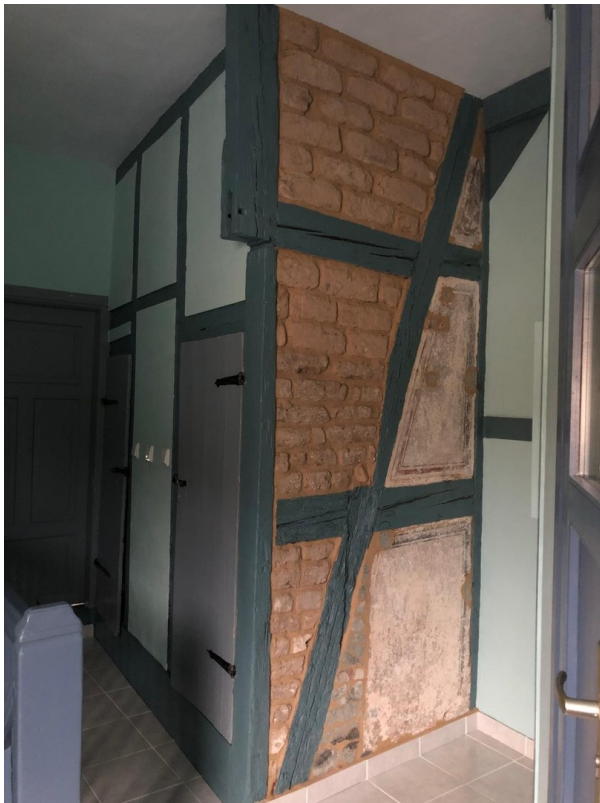
Fachwerk vor Kämmerchen
