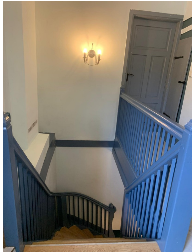
Hausflur mit Eingang 2
