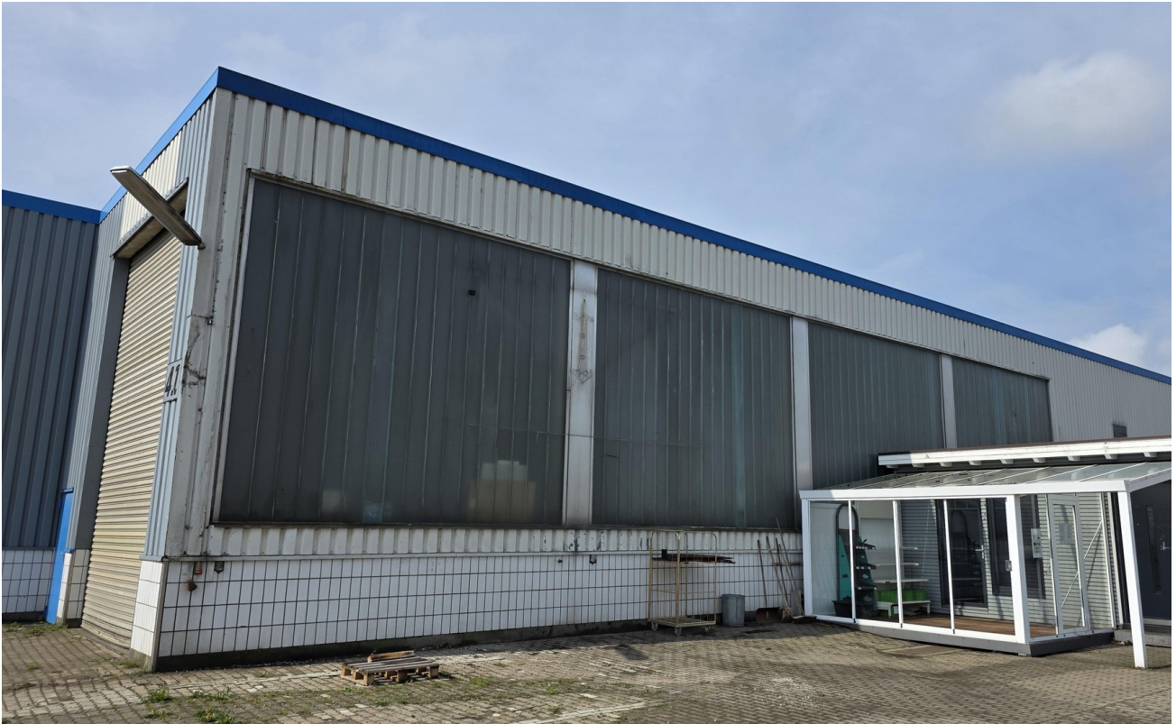
Halle rechts + Büro
