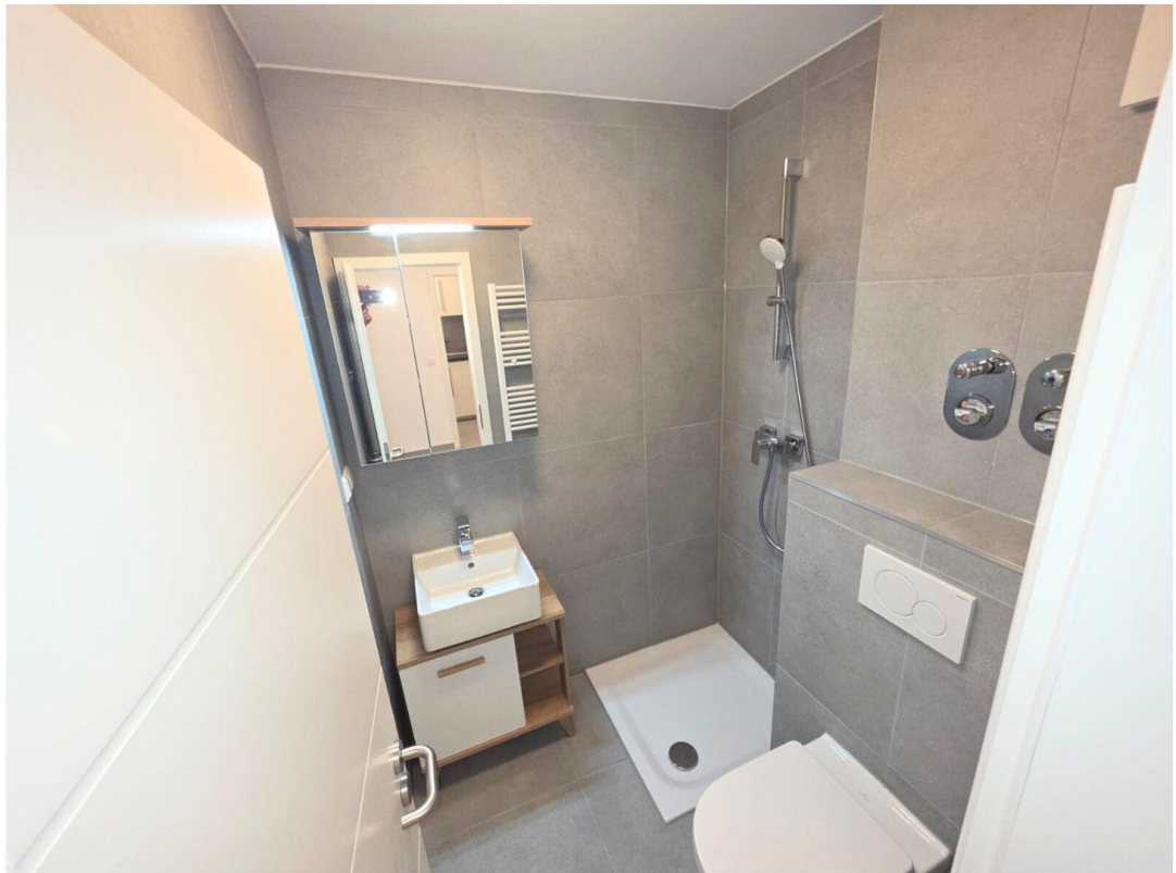
Lüfter, deckenhoch gefliesst
