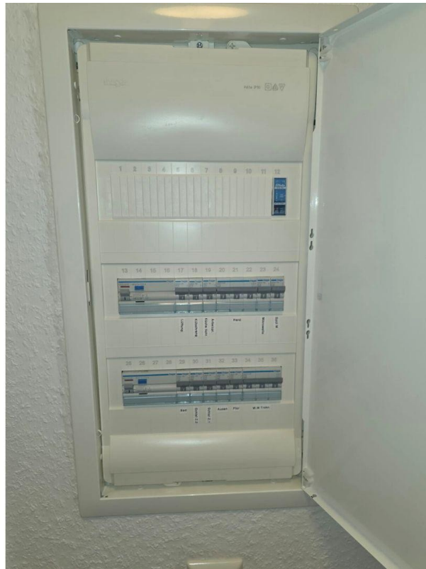
Komplette Elektrik neu
