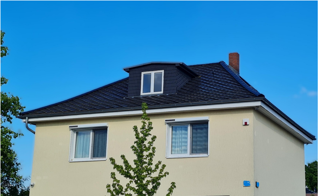
Hausansicht von vorne Straße
