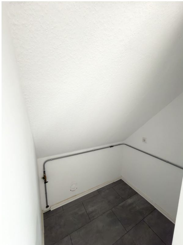
Badezimmer OG (Waschmaschine)
