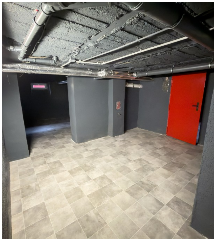
EINGANGSBEREICH DES KELLERGESCHOSSES
