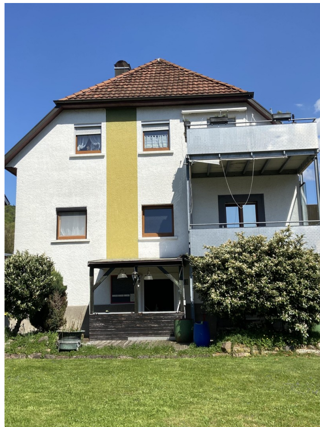
Seitenansicht links mit Balkon
