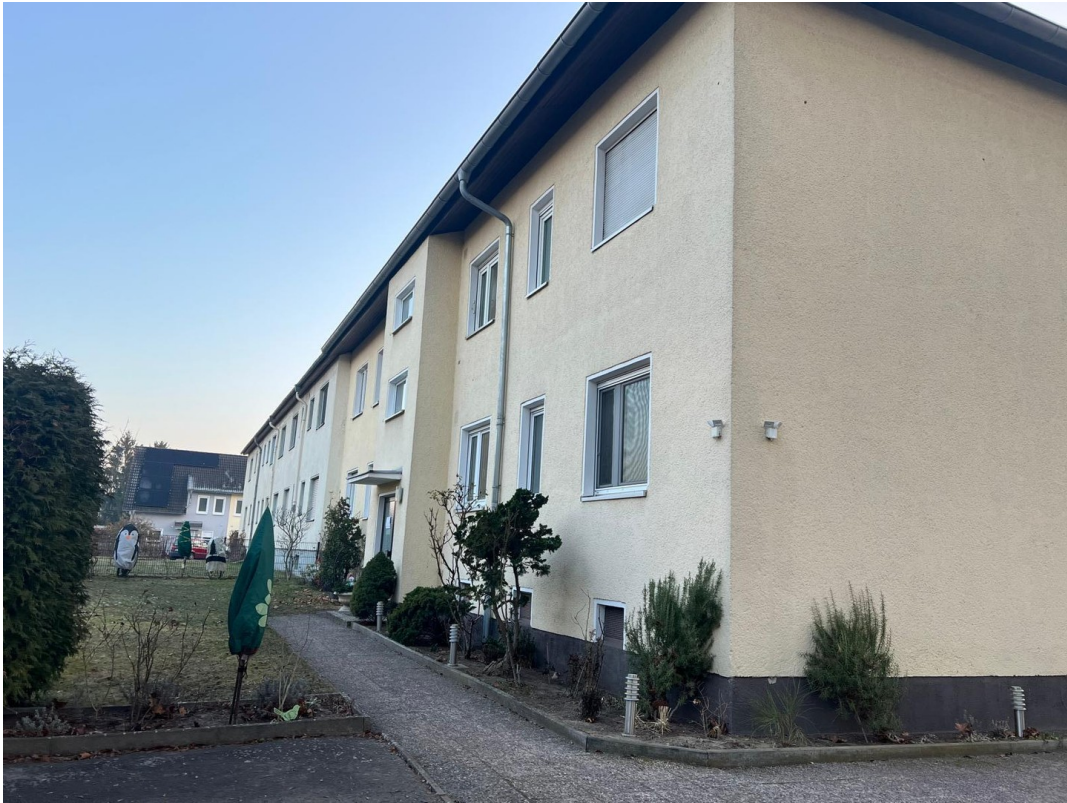
Außenansicht hinten / Eingang
