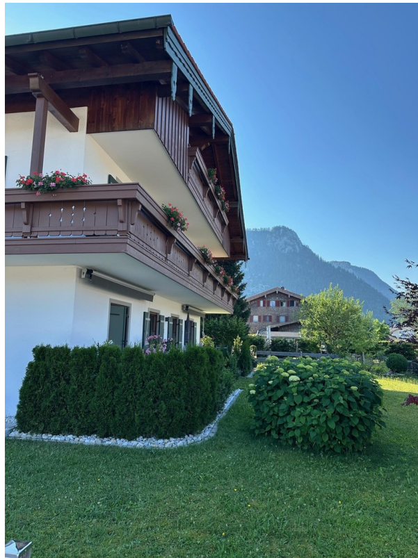
Blick nach Nordost / Garten
