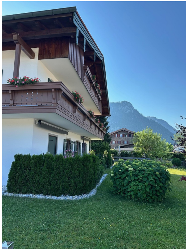
Blick nach Nordost / Garten
